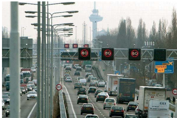
A13 bij Overschie vanaf het viaduct aansluiting Berkel Bron: www.autosnelwegen.nl
